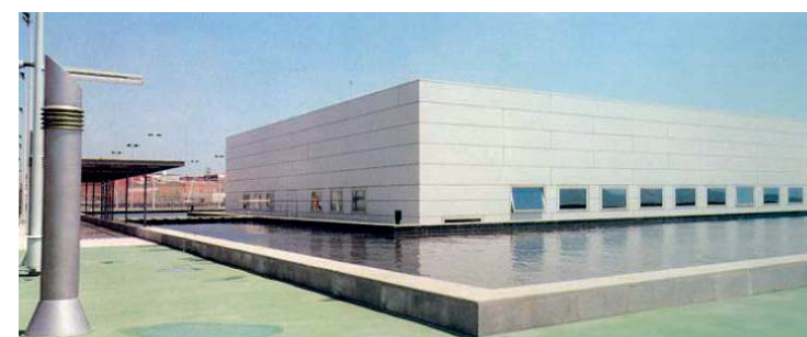
Dipòsit de la Font Santa
